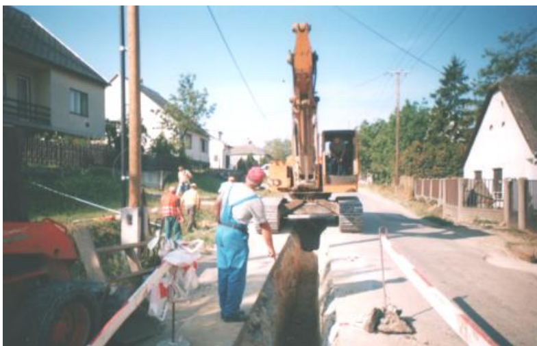
Csatornaépítés a Kossuth utcában
